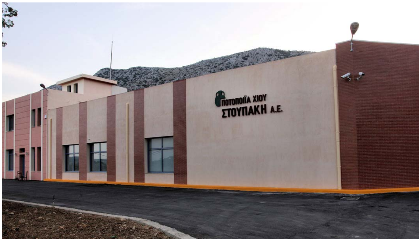
Οι νέες εγκαταστάσεις της «Ποτοποιίας Χίου Στουπάκη Α.Ε.»
