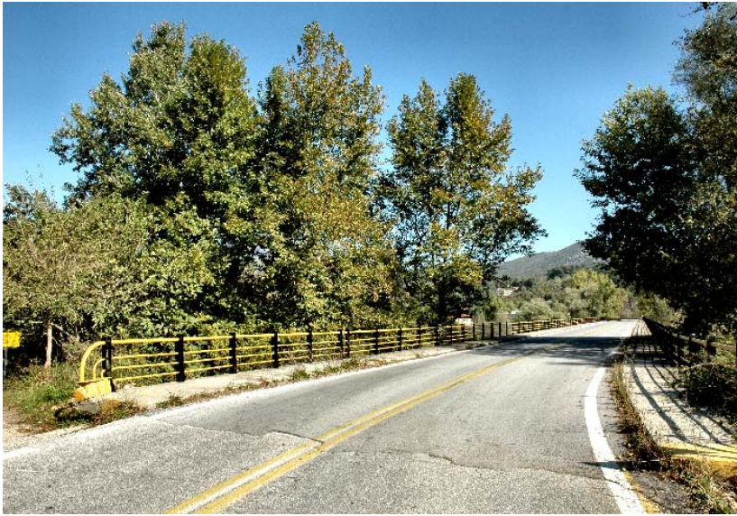
Η γέφυρα του Νέστου στη Σταυρούπολη
